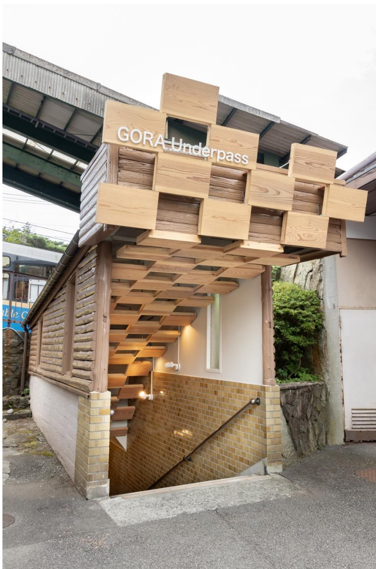
上) GORA Underpass 右) リニューアル前の「一般通路」
